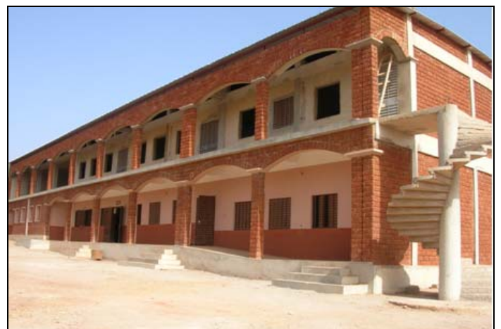
« Établissement Louis-Querbes » à Banfora. Bloc-classe 2008.
