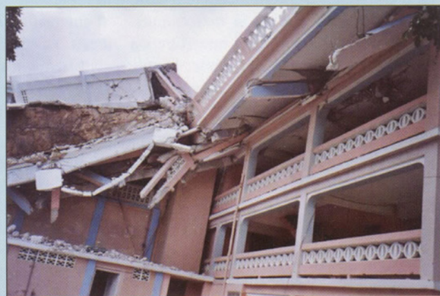
Affaissement du toit de l'aile gauche, au-dessus des chambres et de l'atelier au niveau du sol, tel qu'illustré sur ces 2 photos.
