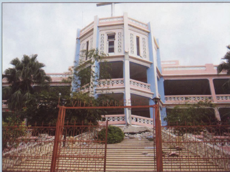
Le 1 er étage et l'entrée principale de la Villa Manrèse ont disparu, écrasés par les deux étages supérieurs, le 2 e et le 3 e que l'on aperçoit sur cette photo.
