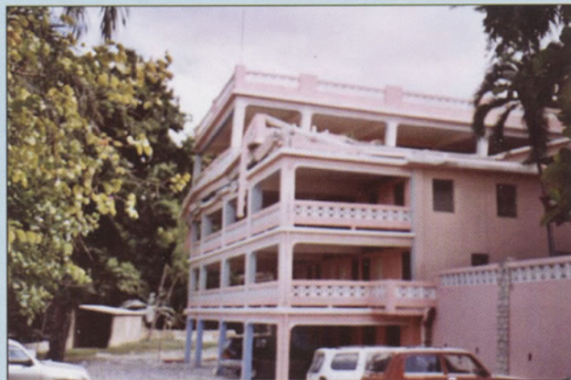
Affaissement du toit de l'aile gauche, au-dessus des chambres et de l'atelier au niveau du sol, tel qu'illustré sur ces 2 photos.
