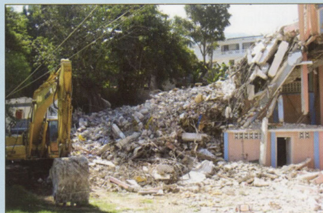
Aperçu de l'opération « démolition » de certaines parties de l'édifice, deux mois après le séisme du 12 janvier 2010.
