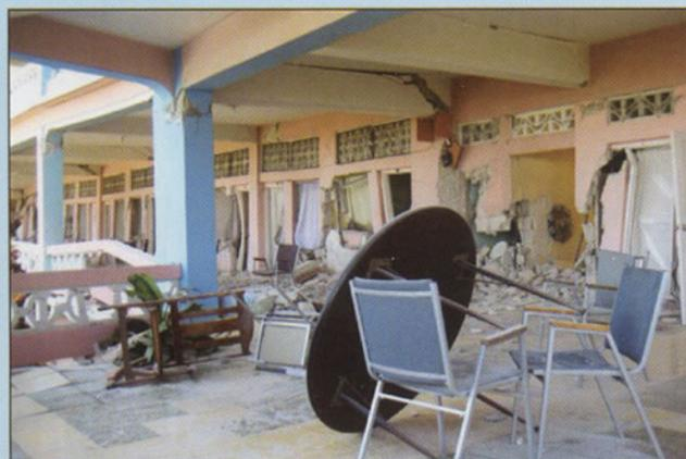
Vue d'un angle de la galerie du 2<sup>e</sup> étage : poutres disloquées, murs lézardés, portes et fenêtres cassées...
