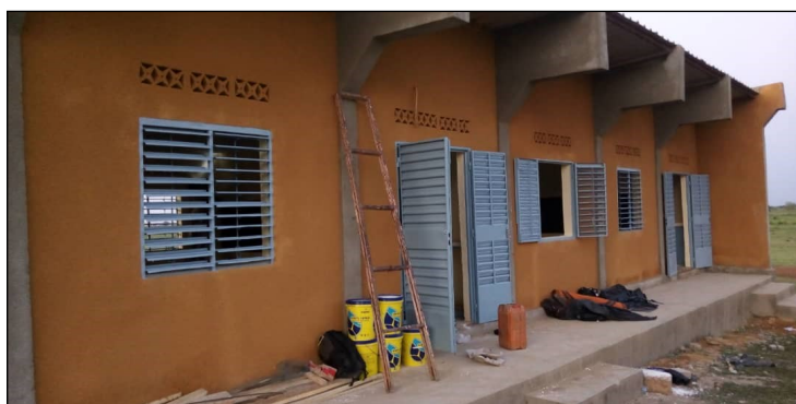
Des travaux de réparation en cours.
