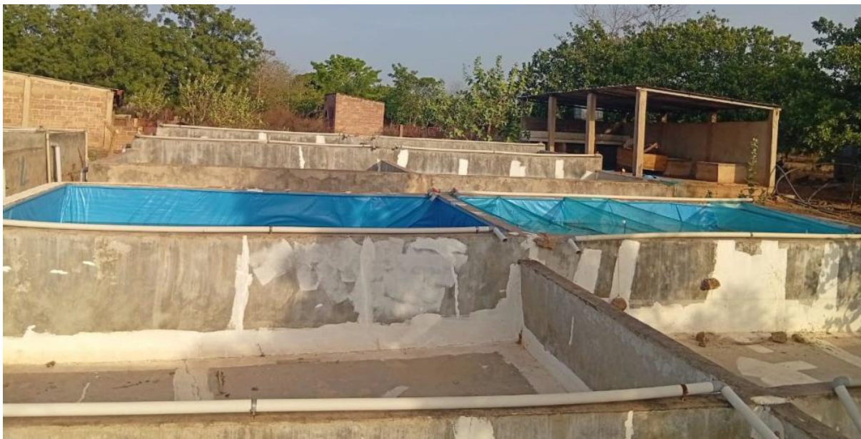
Installation de toile pour faciliter la pisciculture et ainsi assurer une meilleure imperméabilité.
